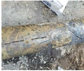
Tubería rota retirada y reemplazada
